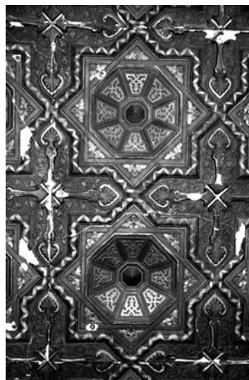
il. 56: Sala mauretańska w Pałacu w Krowiarkach, koniec XIX w., sufit o tłoczonych w metalu kasetonach, stan z 2011 roku, fot. A. Syma.
