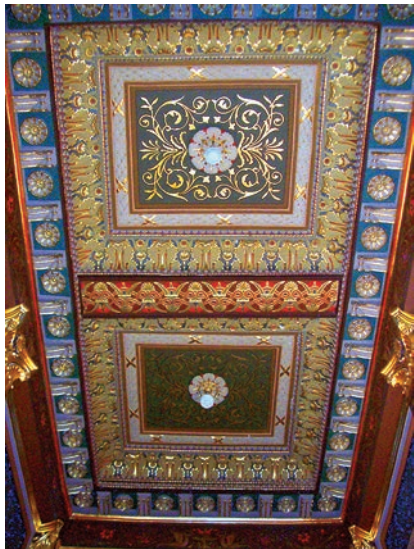
il. 58: Pałac Goldsteinów w Katowicach, 1874-1875, widok stropu klatki schodowej, stan z 2012 roku, fot. S. Rotowska.
