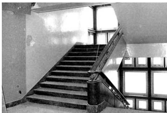
il. 30: Główna klatka schodowa, Pałac Młodzieży w Katowicach, stan z 2013 roku, fot. A. Borowik.
