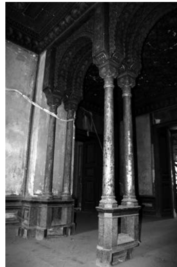
il. 52: Sala mauretańska w Pałacu w Krowiarkach, koniec XIX w., kapitele o metalowych trzonach i drewnianej bazie, stan z 2011 roku, fot. A. Syma.
