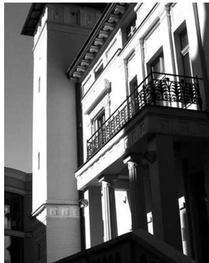
il. 61: Pałac Goldsteinów w Katowicach, 1874-1875, widok od strony ulicy Matejki, stan z 2012 roku, fot. S. Rotowska.
