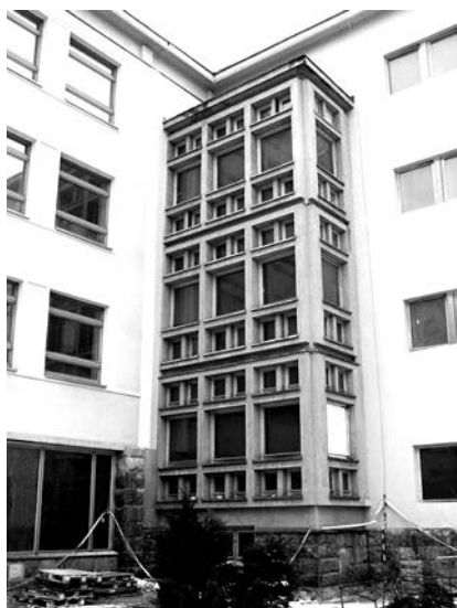
il. 27: Żelbetowa konstrukcja głównej klatki schodowej, Pałac Młodzieży w Katowicach, stan z 2013 roku, fot. A. Borowik.
