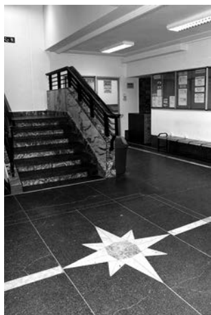
il. 33: Hol przy krytej pływalni, Pałac Młodzieży w Katowicach, stan z 2013 roku, fot. A. Borowik.
