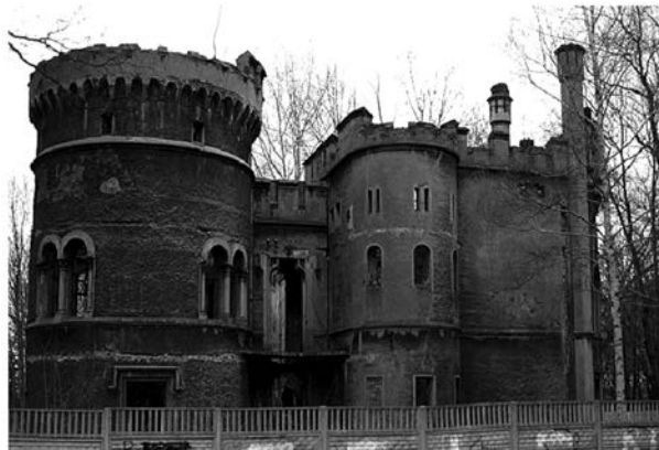
il. 106: Pałac w Miechowicach, stan z 2012 roku, fot. H. Jadwiszczok-Molencka.
