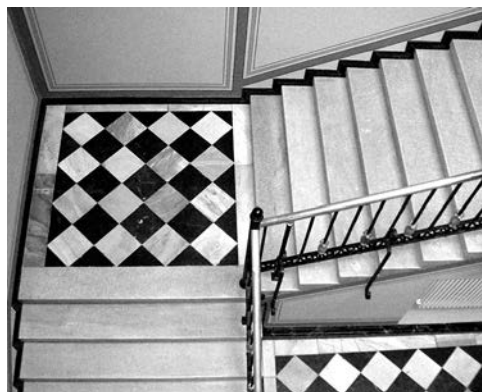
il. 63: Pałac Goldsteinów w Katowicach, 1874-1875, posadzka we wnętrzu klatki schodowej i westybulu, stan z 2012 roku, fot. S. Rotowska.
